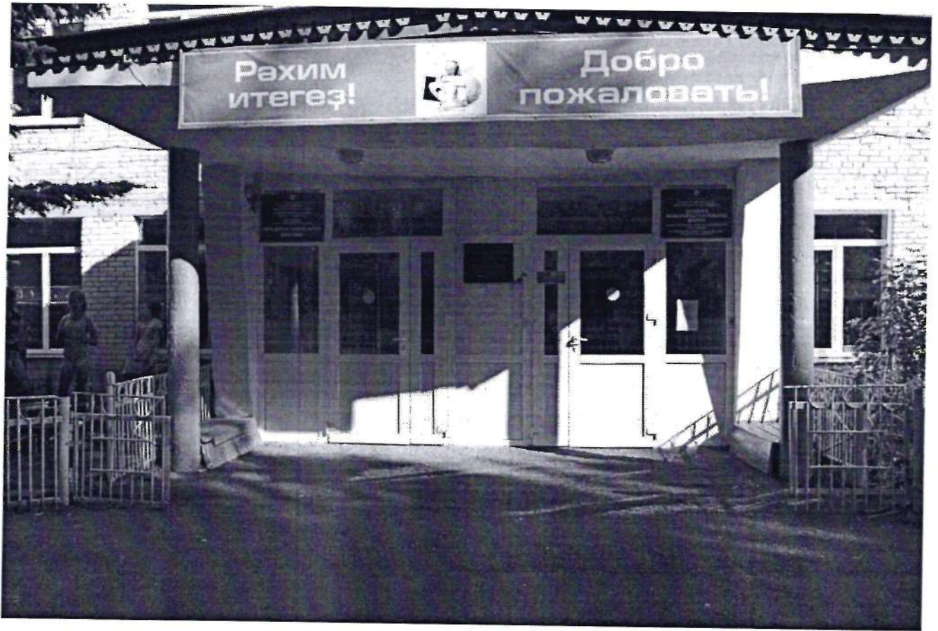
Фото №3. Входная площадка (перед дверью)
